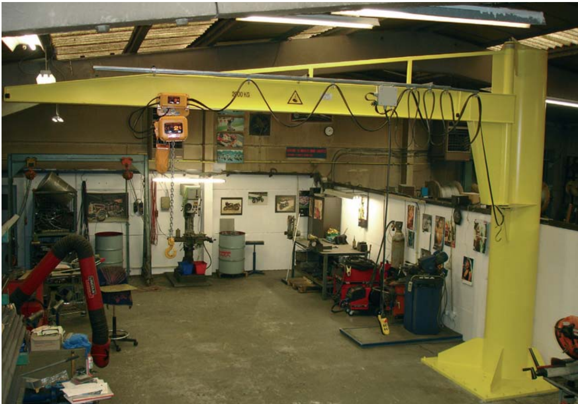
Potence à colonne équipée d'un palan avec chariot électrique KITO Type ERM020LDSDD. Capacité 2000 kg, rotation 270°, hauteur sous poutre 3m35, portée 6 m.
