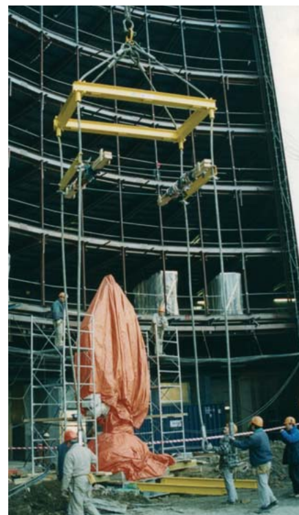
Palonnier cadre 40 tonnes Placement d'une statue. (Charlemagne, Bruxelles 2000)
