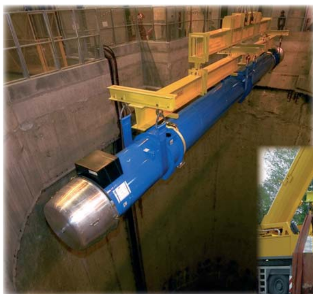
Descente du 1 er cryodipole (35.4t) à 100 mètres profondeur. (CERN, Genève 2005)
