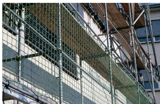
Filets de protection pour façade
