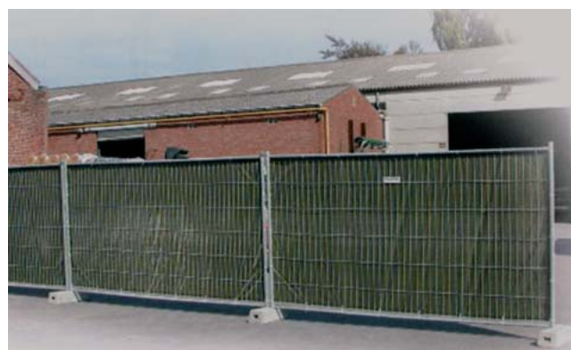
Filets et bâches pour grilles de chantiers mobiles
