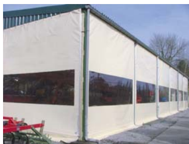
Séparation de hall industriel
