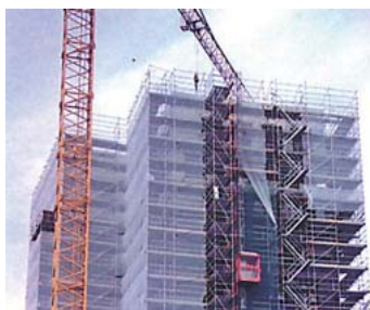
Pour échafaudage (gravats-sables-protection pluie,..)
